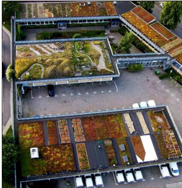
Şekil 3.16. EcoCity Augustenborg Yeşil çatı uygulaması [75].
