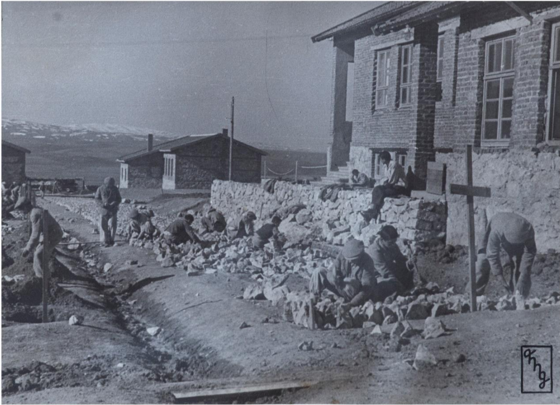
Fotoğraf 15. 1942 - Yol Yapımı
