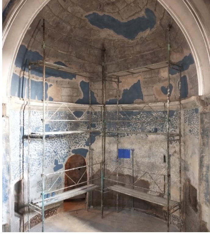
Görsel 40: Duvar Onarım Aşamaları (2), Proje Şantiye Şefi Murat Karlı
