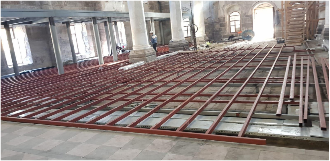
Görsel 45: Meryem Ana Kilisesi Yükseltme Zemin (2), Proje Şantiye Şefi Murat Karlı
