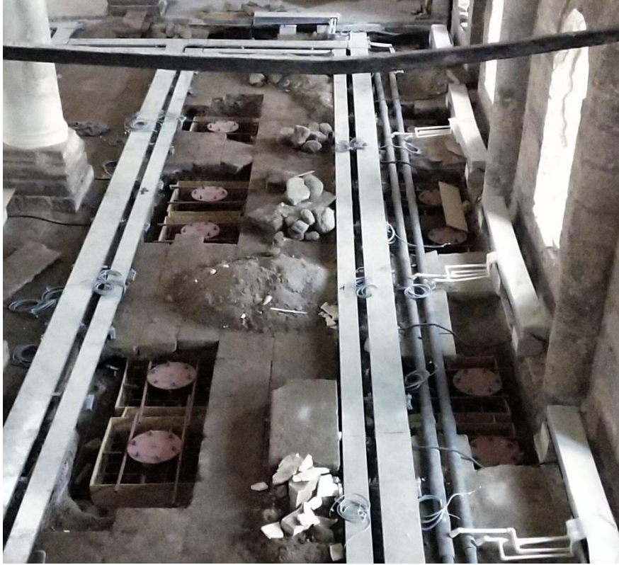
Görsel 72: Havalandırma Boruları, Proje Şantiye Şefi Murat Karşlı
