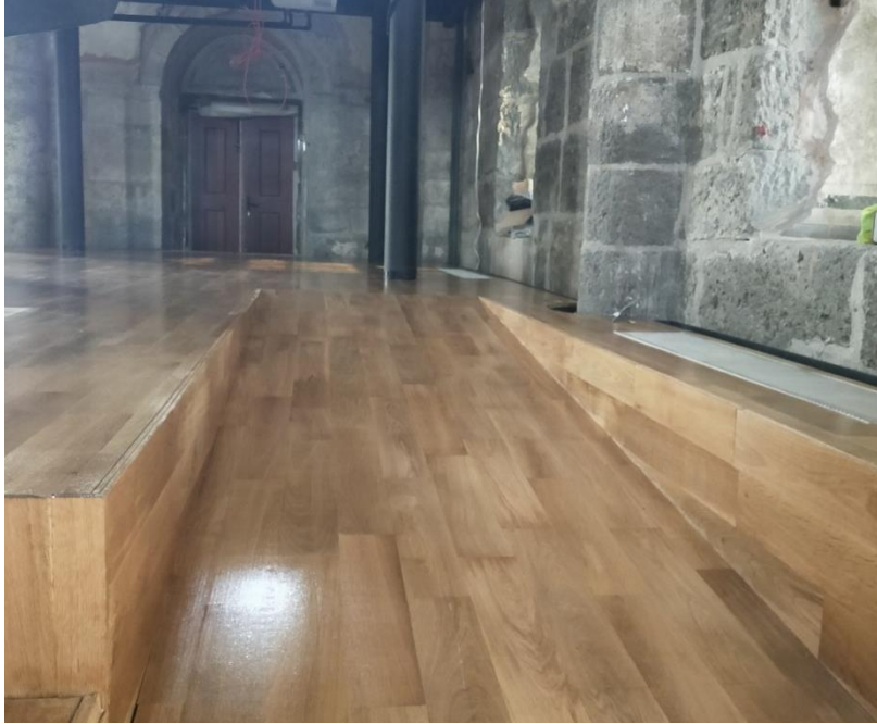
Görsel 52: Zemin Kat Rampa Malzemesi, Proje Şantiye Şefi Murat Karşlı
