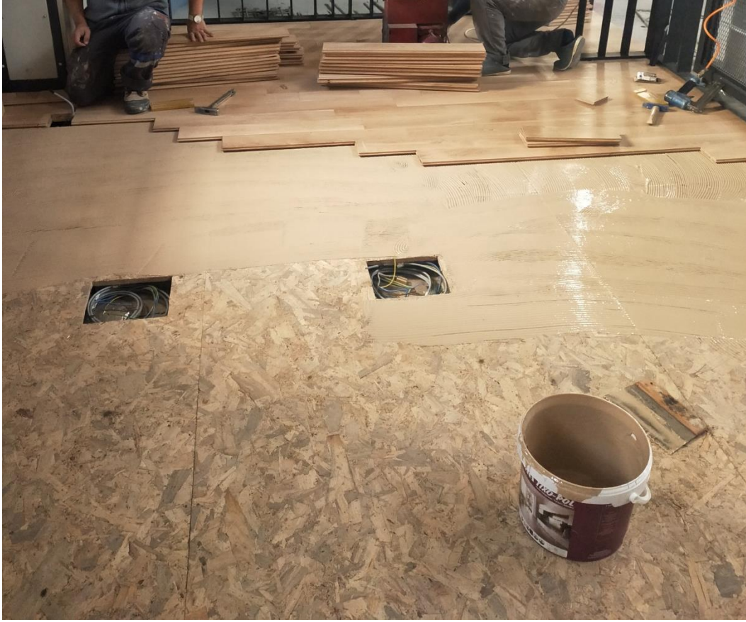
Görsel 53: Asma Kat Zemin Malzemesi, Proje Şantiye Şefi Murat Karlı
