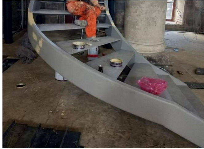
Görsel 55: Merdiven Boyama Aşaması, Proje Şantiye Şefi Murat Karşlı
