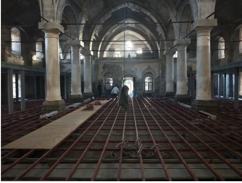
Görsel 44: Meryem Ana Kilisesi Yükseltme Zemin (1), Proje Şantiye Şefi Murat Karlı
