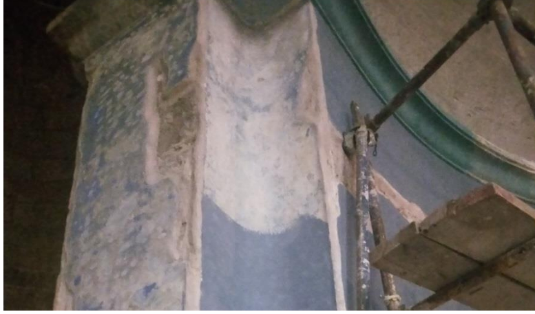
Görsel 38: Duvar Onarım Aşamaları (1), Proje Şantiye Şefi Murat Karşlı
