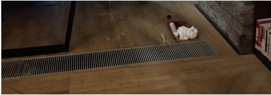
Görsel 73: Havalandırma Kanalı, Proje Şantiye Şefi Murat Karşlı
