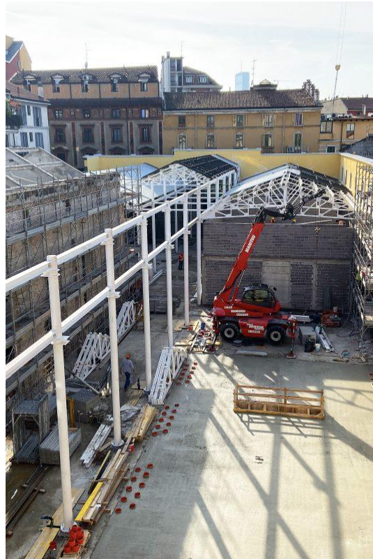
Şekil 55. ADI Tasarım Müzesi Yenileme Çalışmaları
