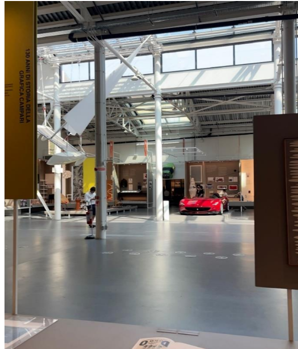
Şekil 72. ADI Tasarım Müzesi İç Mekan Havalandırma Sistemleri
