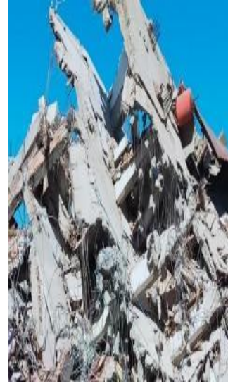
Şekil 2.10. Kusurlu beton kaynaklı hasar, Adıyaman (AFAD, 2023).
