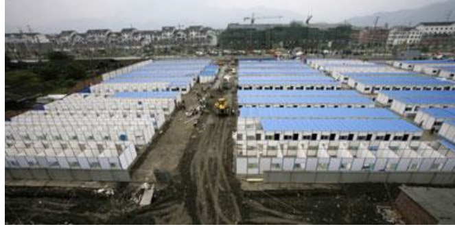
Şekil 3.17. 2008 Wenchuan Depremi Sonrası Geçici Barınma Birimlerinin İnşaat Aşaması(Url 13).
