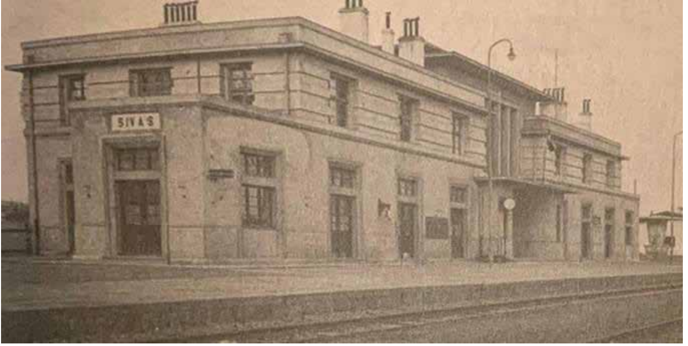
Şekil 13. Sivas Tren Garı, sol cephe görünümü (Tuztaş ve Koç, 2022, s. 81).
