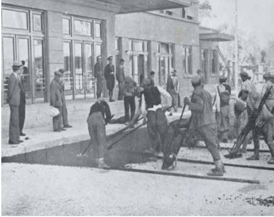
Şekil 22. İstasyon Meydanı inşaatı (Salt Arşivi).
