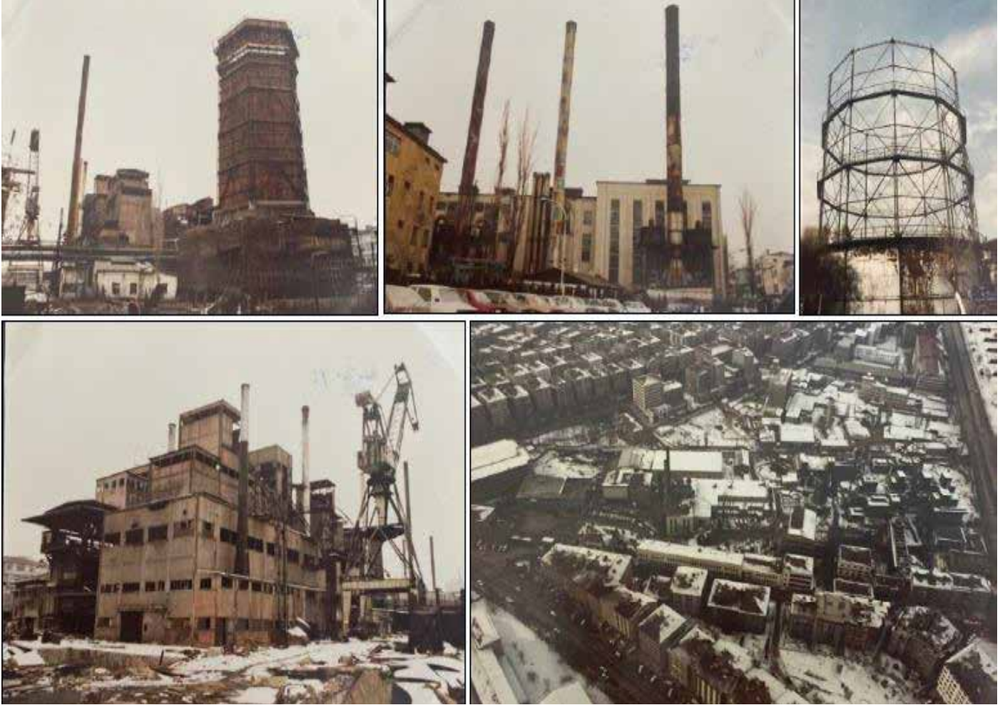
Şekil 8. Maltepe Havagazı Fabrikası ve Elektrik Santrali (Tuzocak, 2022).
