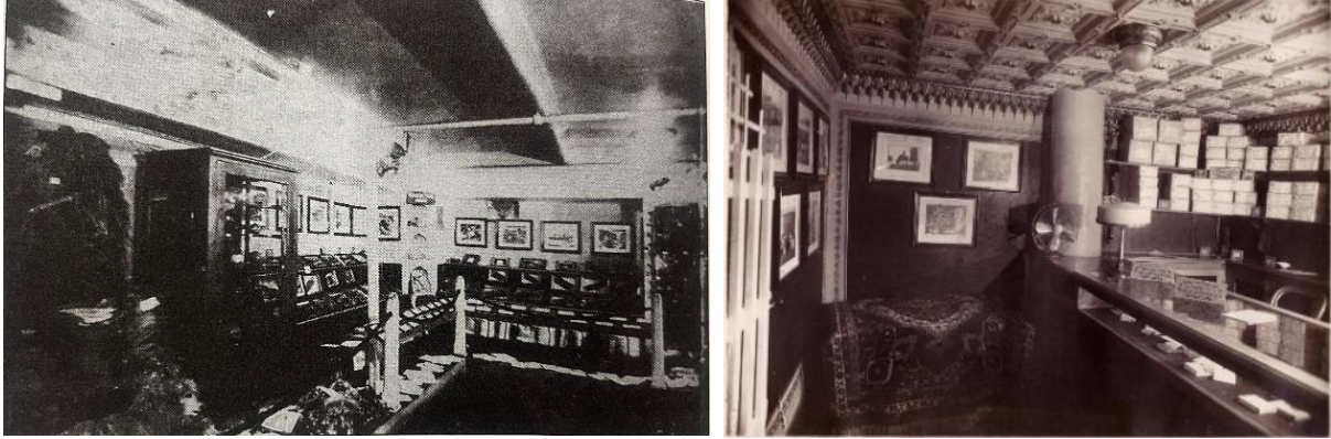
Şekil 4.96. Karadeniz Vapuru Numune Dairesi: İnhisarlar Pavyonu, 1926 (Kaynak: Gürsu, 1935, 2018).
