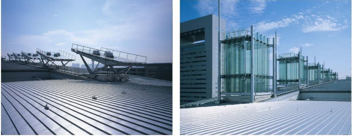
Şekil 4.23 Miraikan Müze Çatısı solda Güneş Panelleri Sağda Rüzgâr Kuleleri Görsel: Miraikan Müzesi Arşivi, erişim tarihi 12/03/2024
