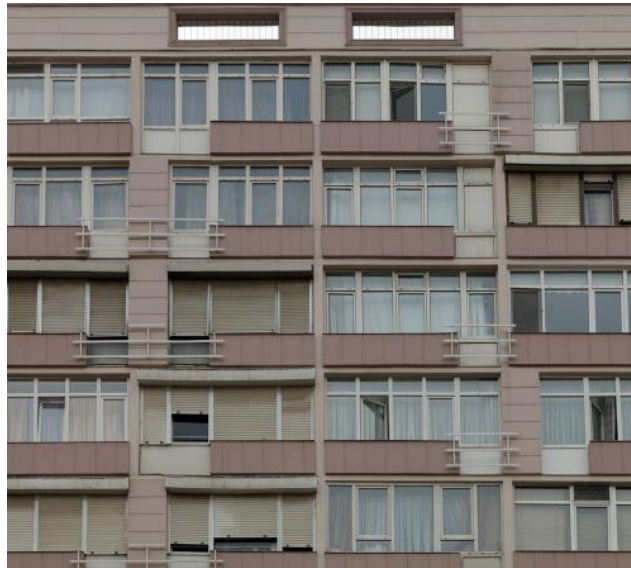
Şekil 3.45. 96'lar Apartmanı Cephe Görünüşü (URL 4).
