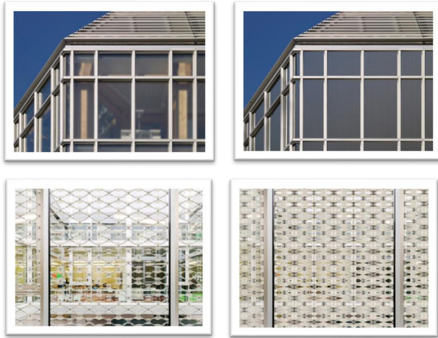
Şekil 2.22. Şekil hafızalı akıllı tekstil ürünü tasarımlarından birisi olan “adaptex” kumaşının örnek kullanımı. Kaynak: Denz vd., 2021
