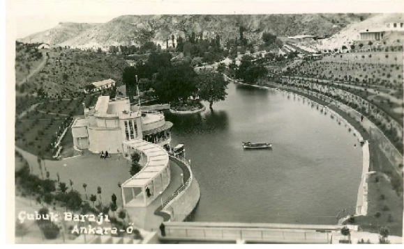
Şekil 3.5. Çubuk Barajı ve Baraj Gazinosu 1940 [51]
