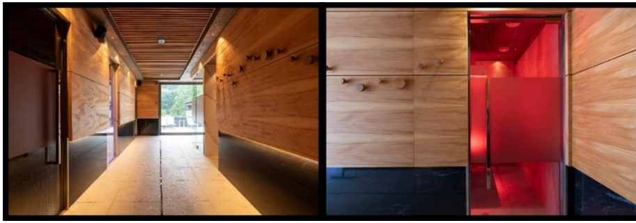
Şekil 2.54. Sedir Ağacının Duvar ve Tavan Yüzeylerinde Kullanımı, Hotel Le Sanglier Des Ardennes, Belçika
