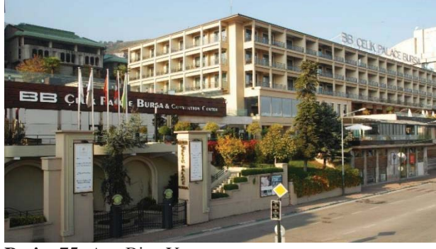
Resim 75: Ana Bina Yapısı
