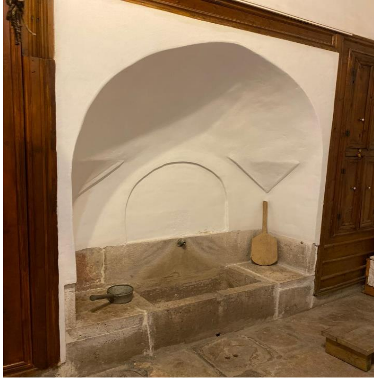
Şekil 5. 69. Atatürk Evi restorasyon sonrası merdiven başlangıç sahanlığındaki niş ve içinde bulunan çeşme [79]
