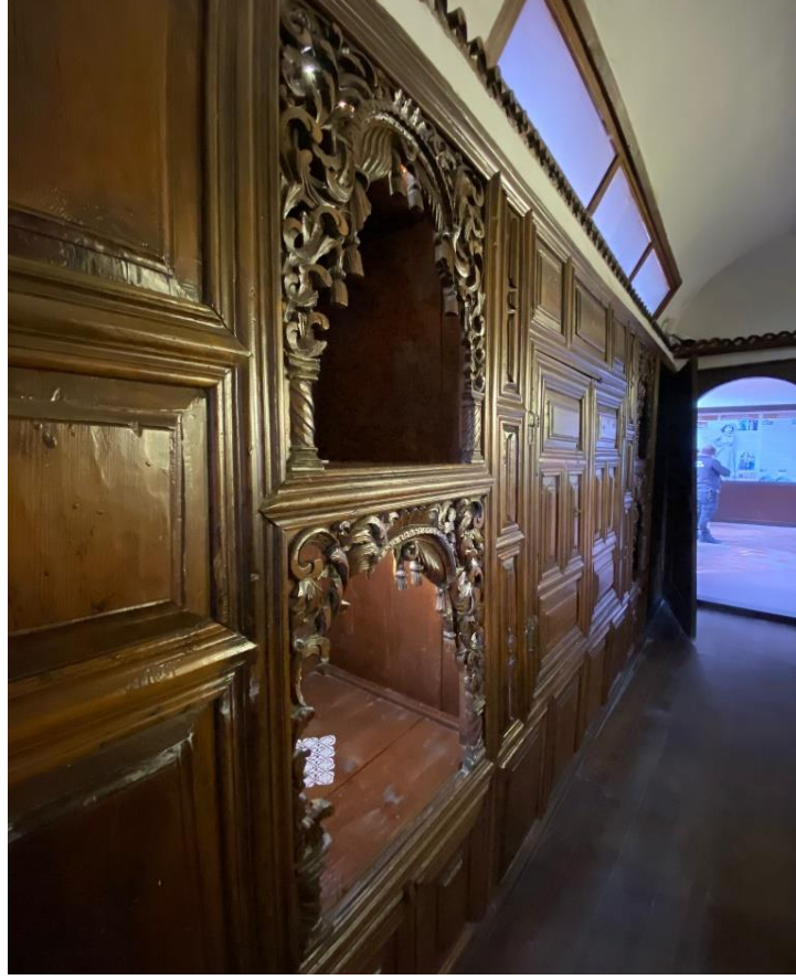
Şekil 5. 34. Latifoğlu Konağı günlük oda yüklükler üzerindeki aydınlatma pencereleri [79]
