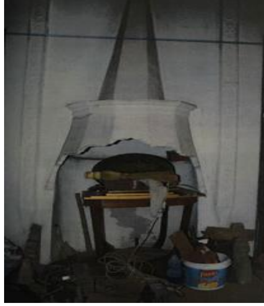
Şekil 5. 16. Latifoğlu Konağı zemin kat oda alçı davlumbazlı ocak [76]
