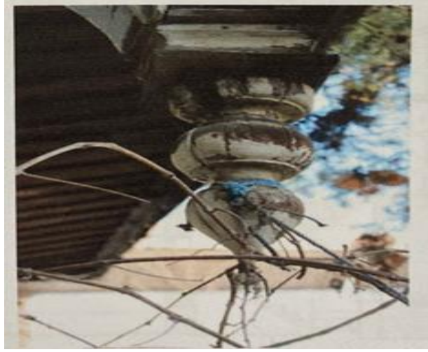
Şekil 5. 84. Balkonda çatıdan sarkıtılmış ahşap süslemeler [76]
