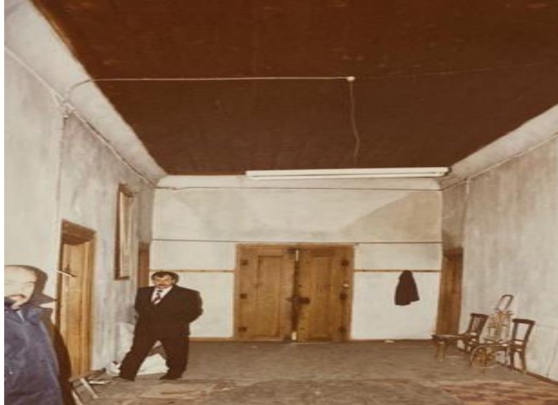
Şekil 5. 94. Atatürk Evi zemin kat sofanın iki yandan görünüşü [76]
