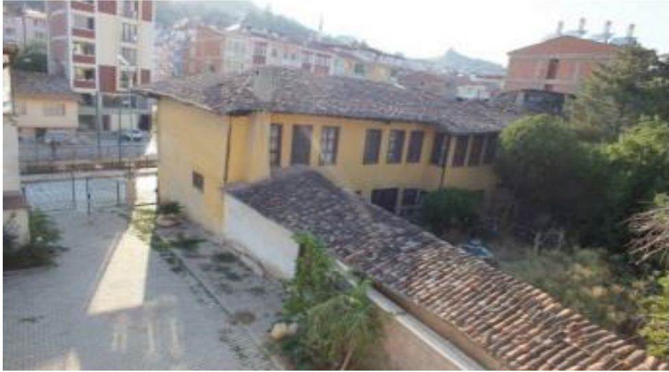
Şekil 5. 101. Canikli Konađı arka bahçesi restorasyon öncesi [93]
