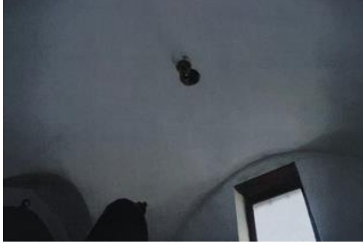
Şekil 5. 14. Latifoğlu Konağı ılıklik mekânı tonoz üst örtü [76]
