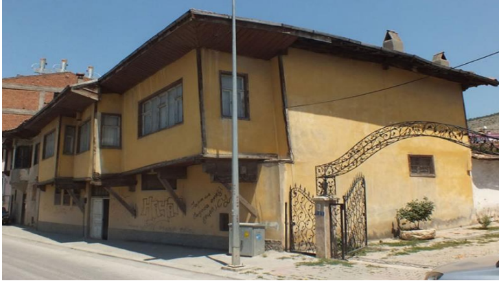
Şekil 5. 117. Canikli Konağı çift kanatlı kapı yanında fayton garajı girişi [76]
