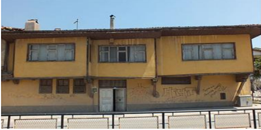
Şekil 5. 100. Canikli konađı çift kanatlı ahşap giriş kapısı-restorasyon öncesi [93]
