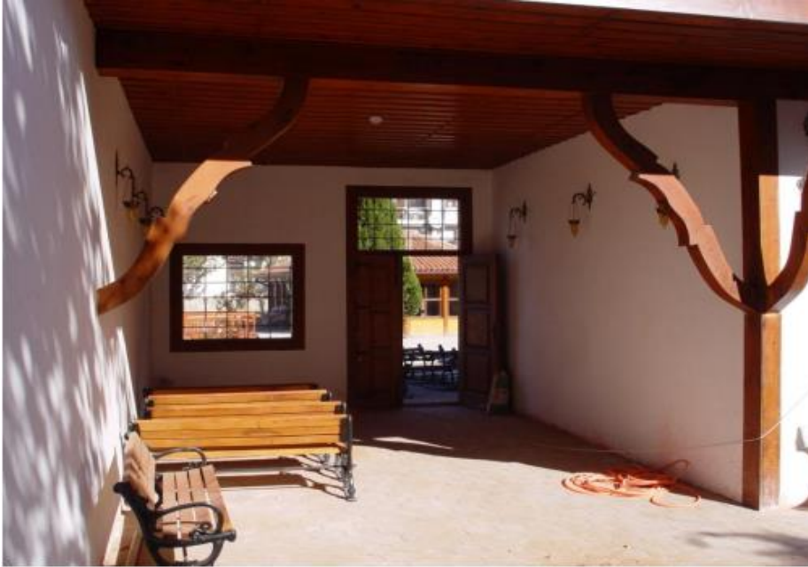
Şekil 5. 143. Muslu Ağa Konağı giriş kapısı [100]
