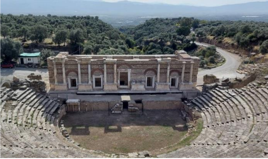
Şekil 5.2.2.1.11. Tiyatro sahne binası kuzey cephe Ekim 2021. Kaynak: [149]
