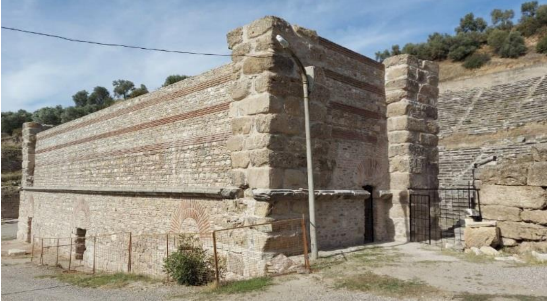
Şekil 5.2.2.1.10. Tiyatro sahne binası güney ve doğu cephe Ekim 2021. Kaynak: [149]
