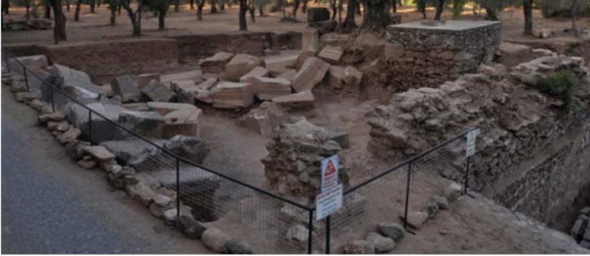
Şekil 3.3.5.3. Çarşı Bazilikası kuzey duvarı üzerindeki su deposu tahribatı [110]
