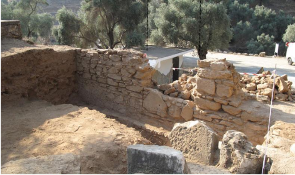
Şekil 3.3.4.6. Kazıları sırasında açığa çıkarılan ve sonraki dönemlerde kapatılmış olduğu tespit edilen kapı açıklığı [110]
