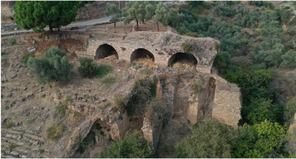
Şekil 5.2.2.2.7. Merkez Köprü-II. Kaynak: [110]
