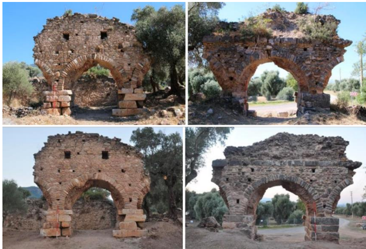
Şekil 5.2.3.21. Kuzeydeki kemerli yapının restorasyon öncesi ve sonrası. Kaynak: [152]
