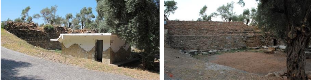
Şekil 5.2.3.7. WC yıkım öncesi ve sonrası. Kaynak: [145]
