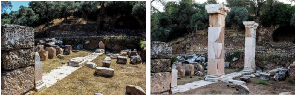
Şekil 5.2.3.22. Nysa Çarşı Bazilikası Kemer Ayakları Anastilosis Projesi öncesi ve sonrası. Kaynak: [149]
