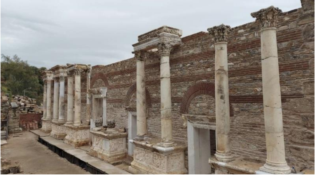
Şekil 5.2.2.1.12. Tiyatro sahne binası kuzey cephe Ekim 2021. Kaynak: [149]
