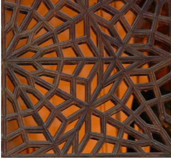
Şekil 3.10. Mevlâna Müzesinde bulunan korkuluktan bir görünüm [44].
