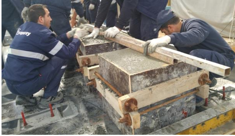
Şekil 4.4. Hedef beton üretimine ilişkin görsel.
