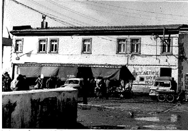
Şekil 93. 1980'li Yıllara Ait Fotoğraf Balıkxane Binası Ön Cephesi Kaynak: İzmir 1 No' lu Koruma Kurulu Fiş
