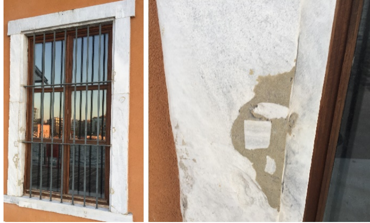
Şekil 104. Pencere ve Sövelerin Onarımı Kaynak: G. Büke Doğru'nun Kişisel Arşivinden Alınmıştır.
