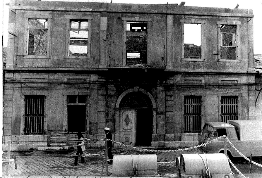
Şekil 46. 1980'li Yıllara Ait Fotoğraf Taş Bina Ön Cephesi
