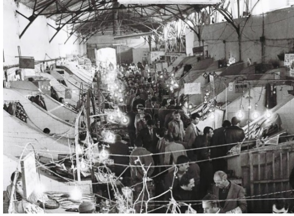
Şekil 87. 1955-1960 Büyük Hol Binası'nın Güney Cephesinde Yer Alan Balık Hali
