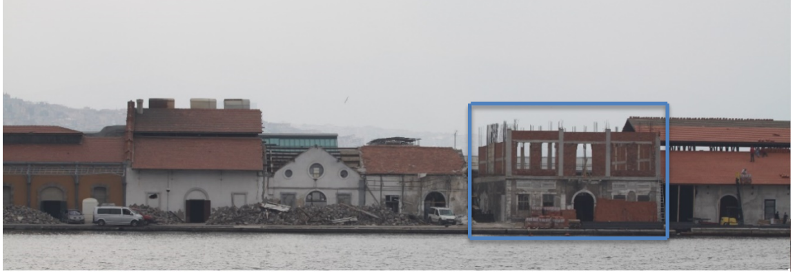
Şekil 57. Taş Bina Restorasyon Çalışmaları 3
