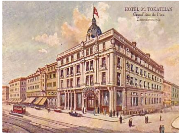
Şekil 2.5: Hotel Mıgırdıç Tokatlıyan -1
