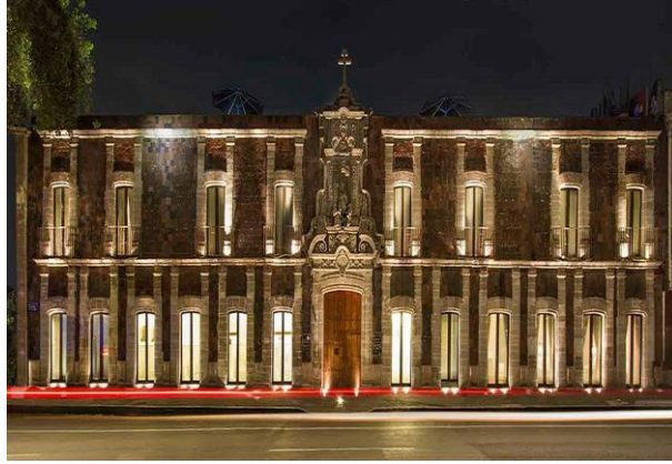
Şekil 2.14: Corre’s Hotel – Dış Cephe
