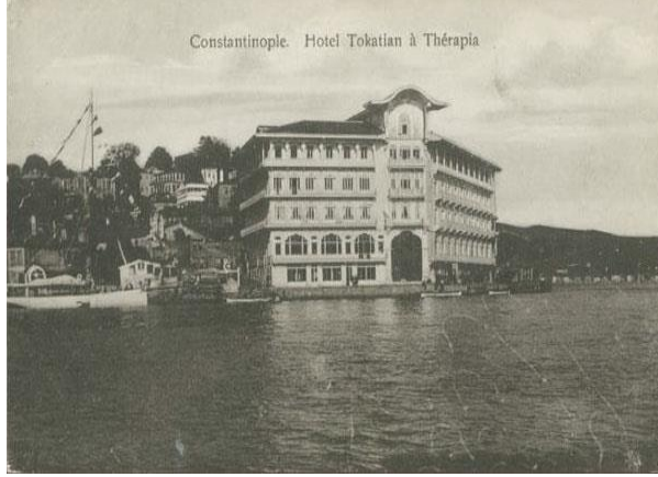
Şekil 2.6: Hotel Mıgırdıç Tokatlıyan-2
