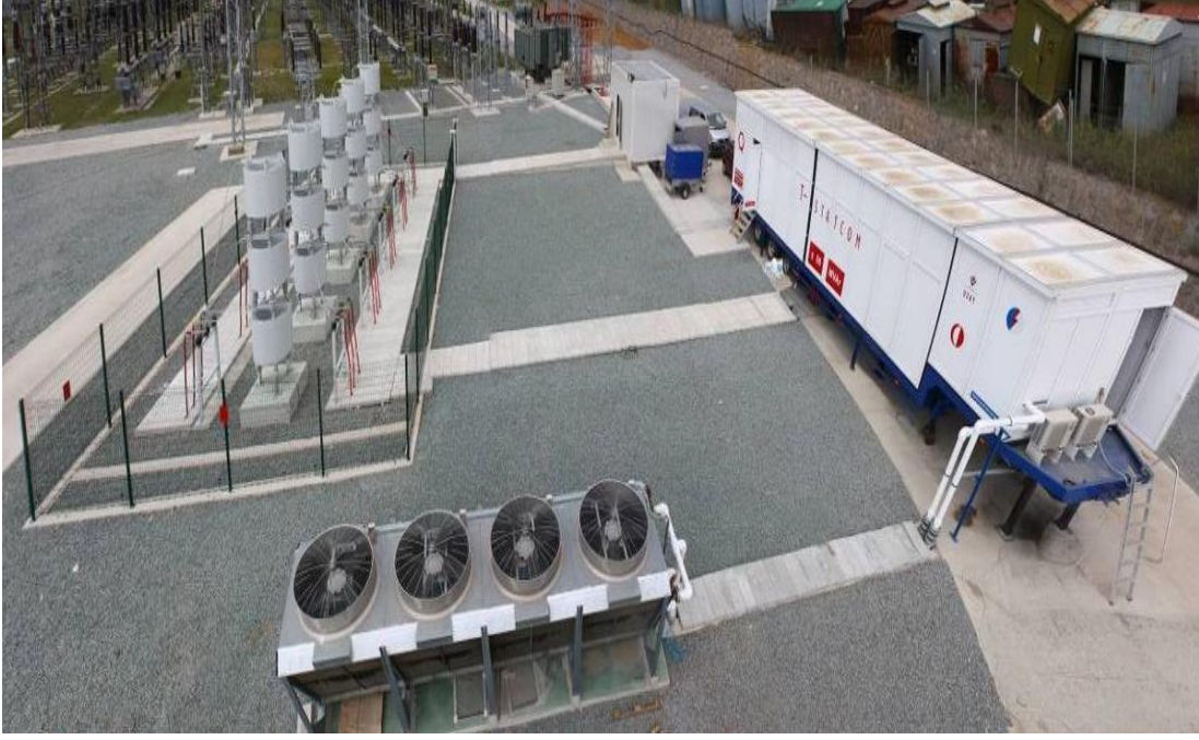
Şekil 1.6 Ankara Sincan TM Bank-B barasına bağlı 154 kV, \pm 50 MVar T-STATCOM Sistemi [14]
