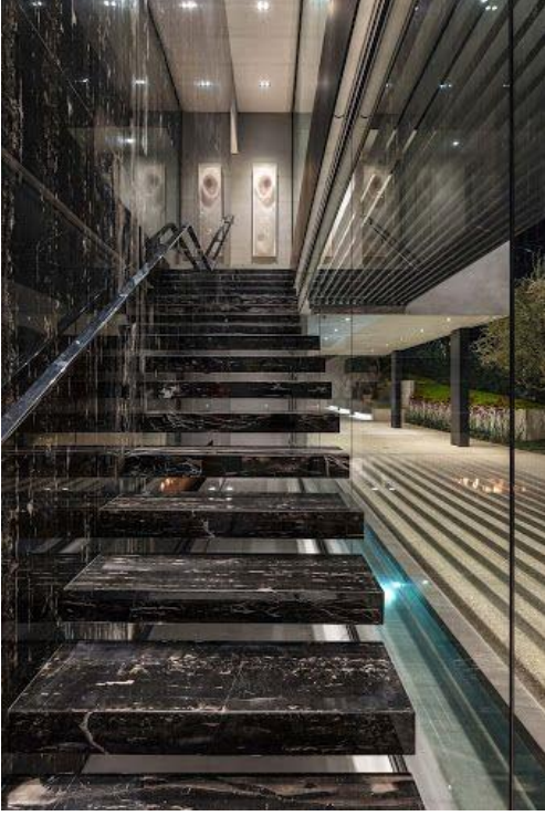
Şekil 12. Granit Kaplama Merdiven Örneği
