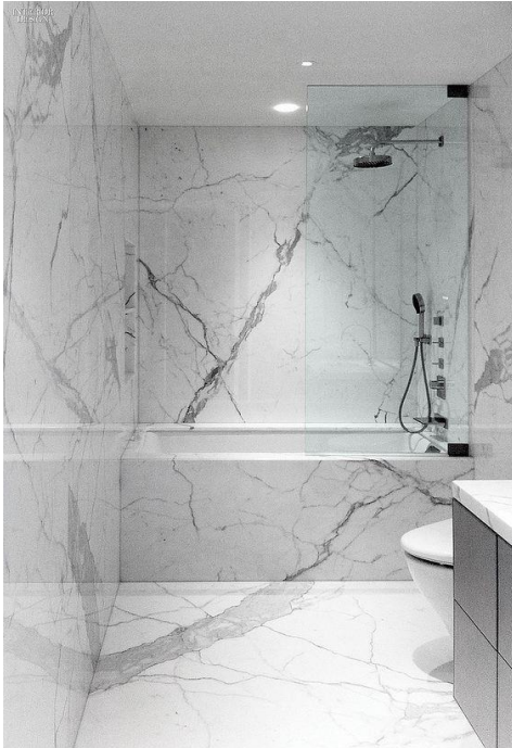
Şekil 10. Islak Hacımda Duvar ve Zemin Yüzeyde Kullanılan Mermer Örneği
