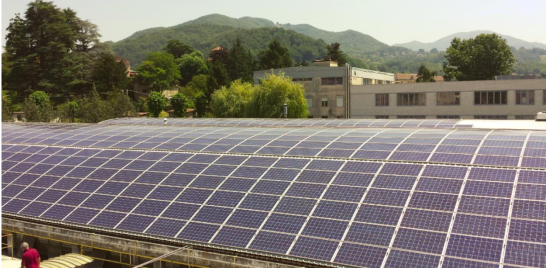
Őekil 3.13 Oval çatıya uyarlanmış farklı eęimlerde panel yerleŐimi
