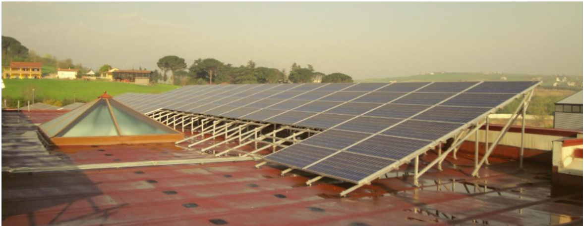
Şekil 3.12 Aynı eğimde, üst üste ve tek sehpa olarak kurulmuş FV sistem örneği
